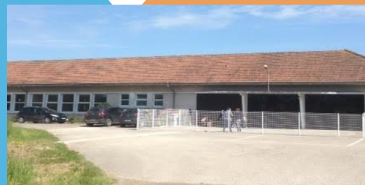
Périscolaire de Damblain (au groupe scolaire)
